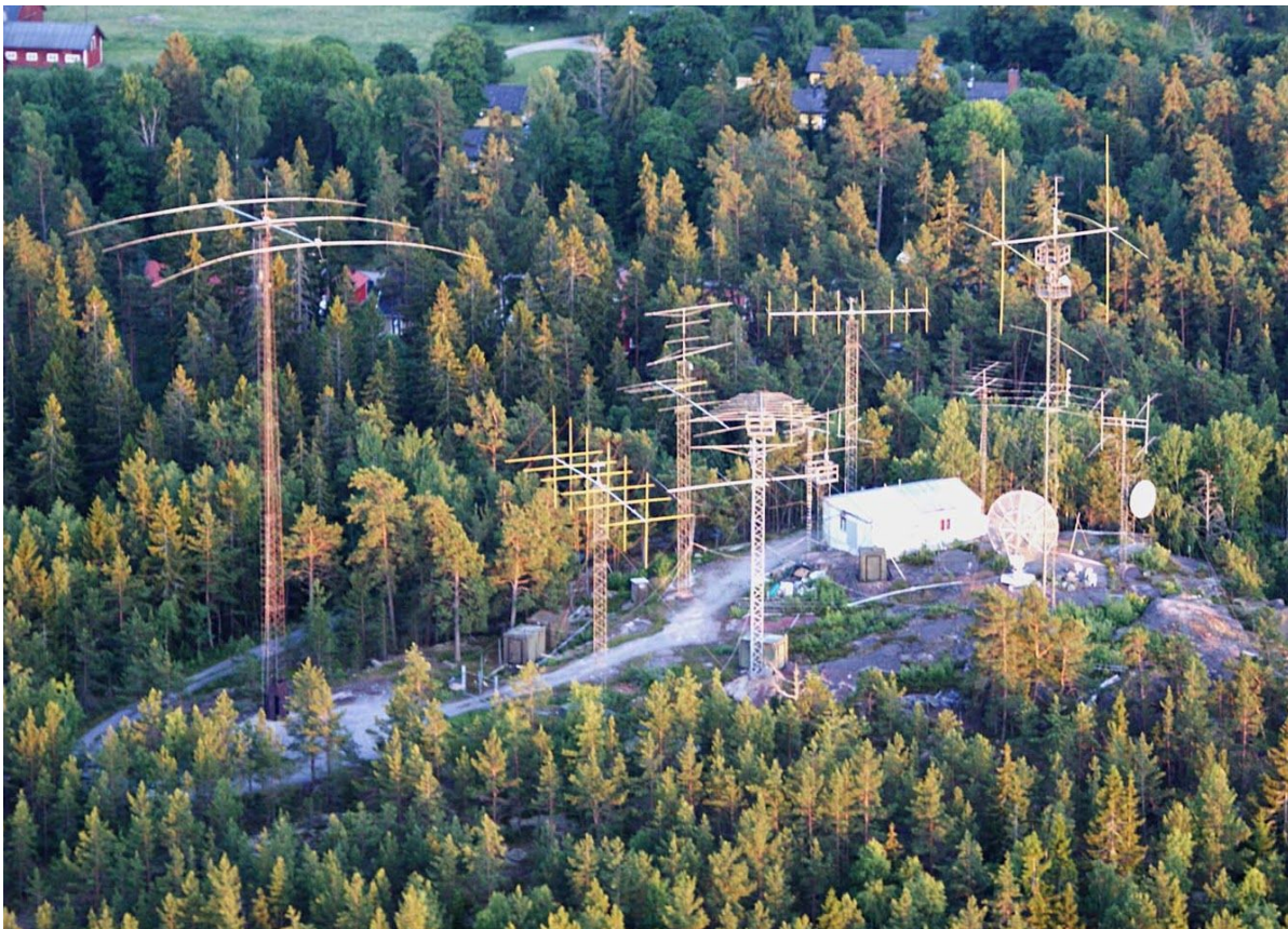
Delar av Kvarnbergets Amatörradioförenings experimentella antennenläggning i Täby/Vallentuna. Antenner och Antennarrayer mellan 1,8MHz till 24GHz.
